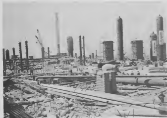
Many of the HDS units are taking shape, changing the refinery skyline. Hopi di e unidennan HDS ta tumendo forme, cambiando e aspecto di refinaria.
